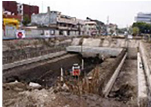
Figura 13a. Construcción losa inferior.
