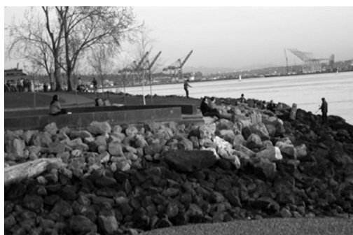
Figura 11: Contención con la roca. Fuente: Fotografía de Guillermo Díaz Arellano.
